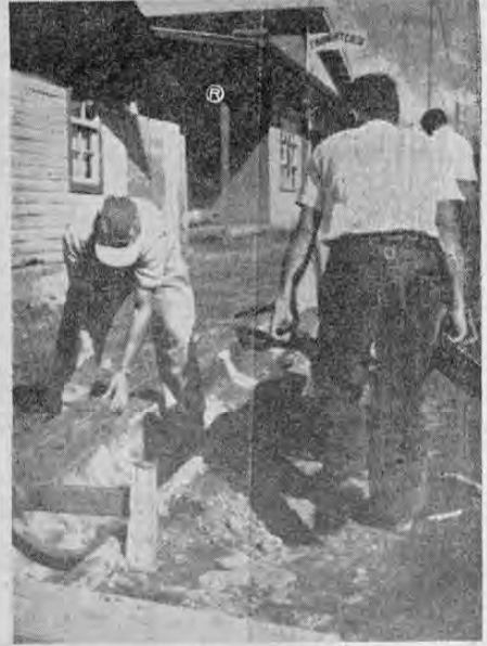
Obreros municipales de Tibás, cuando efectuaban trabajos de colocación de cunetas. Gran cantidad de ellas fueron colocadas.
